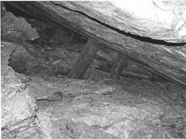
Abb. 12. Arthurstollen, Fundstelle 4650, mittlere Verschalzimmerung in situ von unten, kurz nach der Entdeckung 2003, Foto Th. Stöllner.
