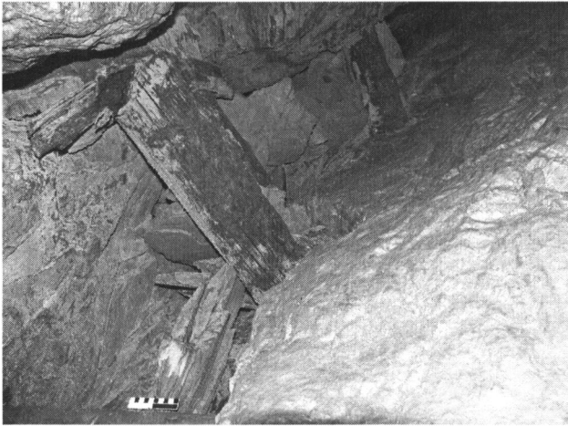
Abb. 14. Arthurstollen, Fundstelle 4650, Verschalzimmerung im Westen des Tiefbaues; dahinter sorgsam geschichteter Versatz, Foto Th. Stöllner.
